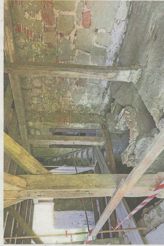
Im Keller der Ziegelei kam ein Drainagesystem zum Vorschein.
